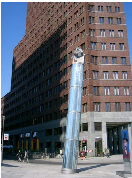
یکی از سه لوله نوری که نور طبیعی روز را به ایستگاه راه آهن زیرزمینی برلین پوتسدامر پلاتنز منتقل می کند
